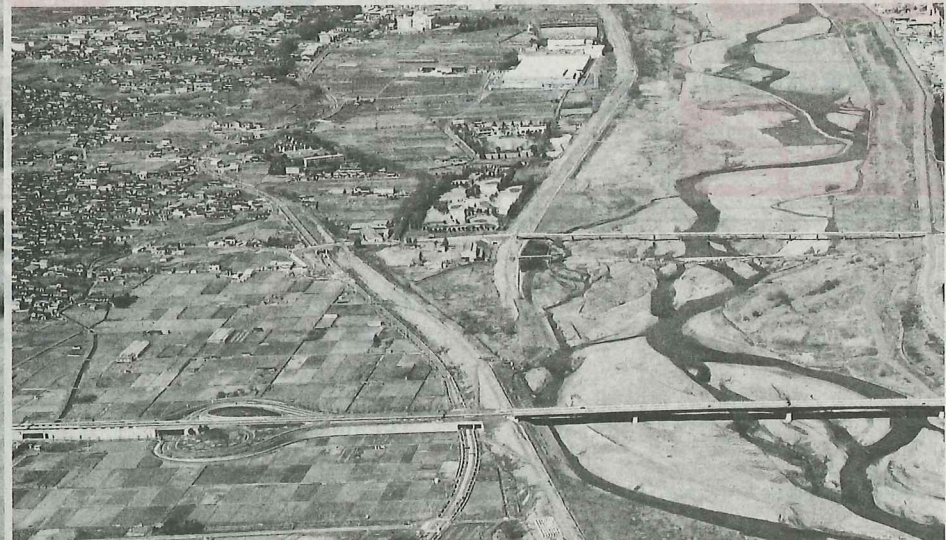
南アルプス市内に残る伝統的治水工法「霞堤」 霞堤...堤防のある区間に開口部を設け、その下流側の堤防を上流の堤防と二重になるようにした不連続な堤防です。その効果としては、上流部で堤防が決壊した時の氾濫水を本川に戻す役割を持っています。
