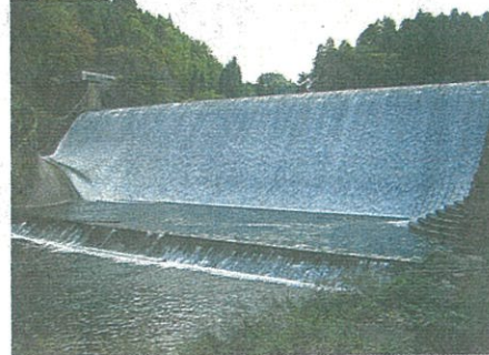
白水溜池堰堤は美しい白波が見もの —どちらも安河内 孝撮影
